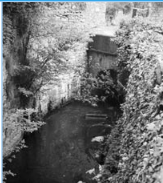
▲ Un point d'attention serait la continuité des cours d'eau.
