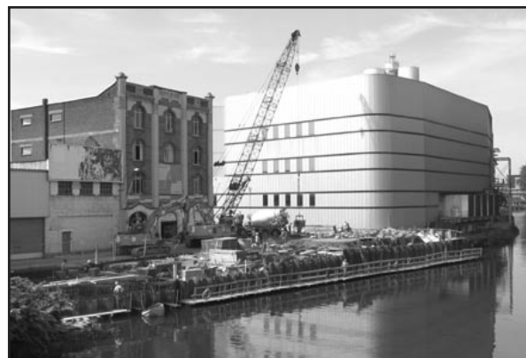
▶ Travaux aux ponts 'Zeeberg' à Alost.
