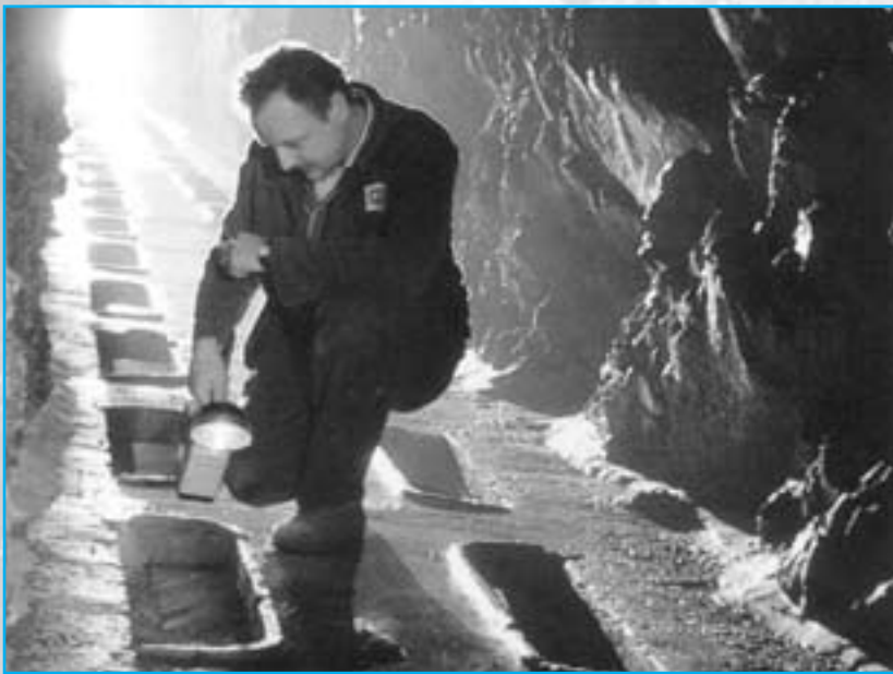
► Captage d'eau potable à Modave.
