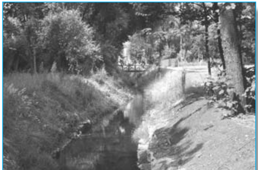
► Des travaux importants (ici remise à ciel ouvert de la Woluwe en région bruxelloise) peuvent modifier radicalement l'état d'altération physique d'une masse d'eau.
