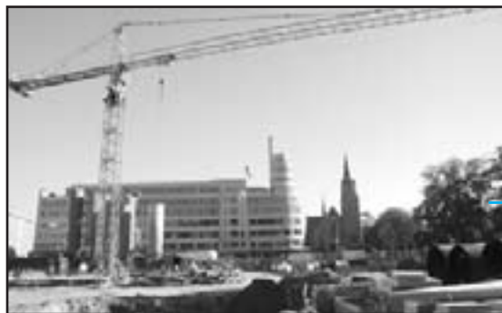
Travaux sur la Place Flagey (source: IEB)
