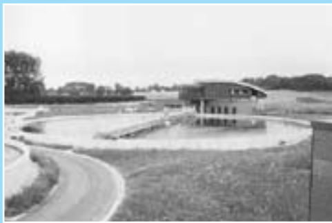
Le bâtiment de supervision de la station d'épuration de Neuville en Ferrain (Source: LMCU, Cellule communication technique Eau et Assainissement).
