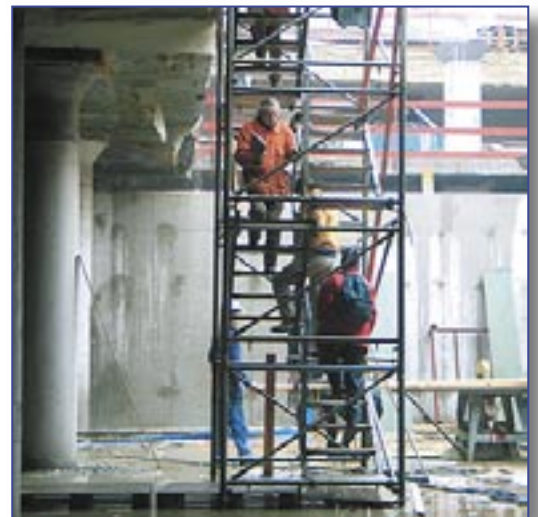
Flageywerf: waterspaarbekken in opbouw
