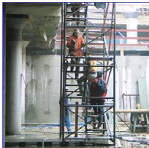
Chantier Flagey: bassin d'orage en construction
