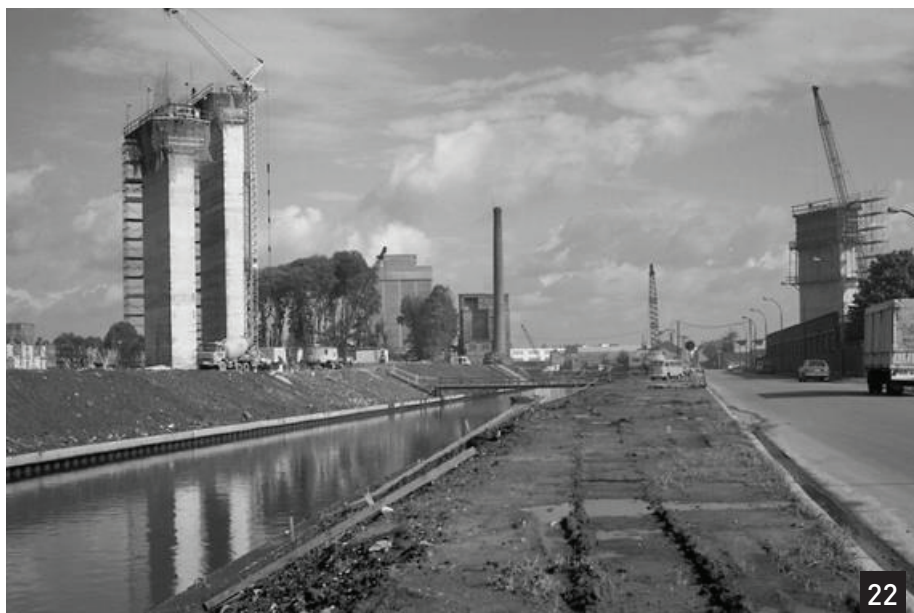
Fig. 22: Zicht op de bouw van het viaduct van Vilvoorde in de jaren 1970.
