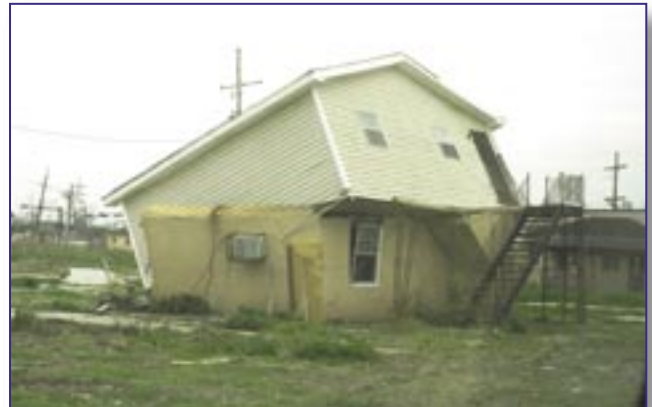
► Eén van de vele beschadigde huizen...
