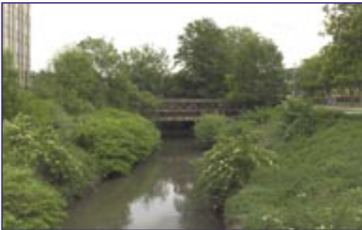
► En bordure du boulevard Paepsem: un tronçon de Senne insoupçonné
