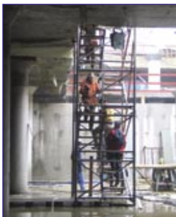
► Het stormbekken Flagey tijdens de bouwwerken
