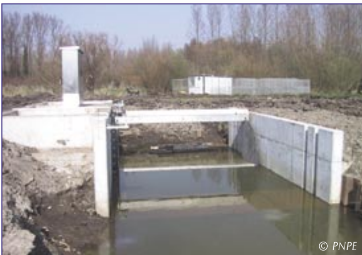
► Mobile stuw op de Verne de Bury, voorzien van een vistrap
