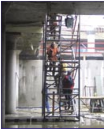
► Le bassin d'orage Flagey au moment de sa construction
