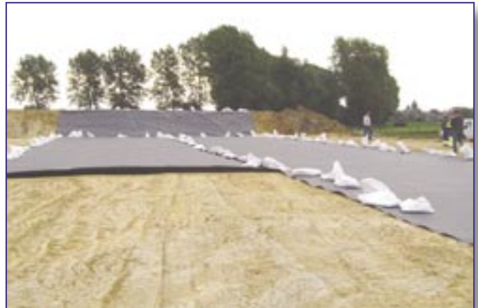
► Rebaix - Centre d'enfouissement - Septembre 2006: pose d'une seconde bande de la membrane étanche avant la réalisation de la soudure entre ces deux bandes
