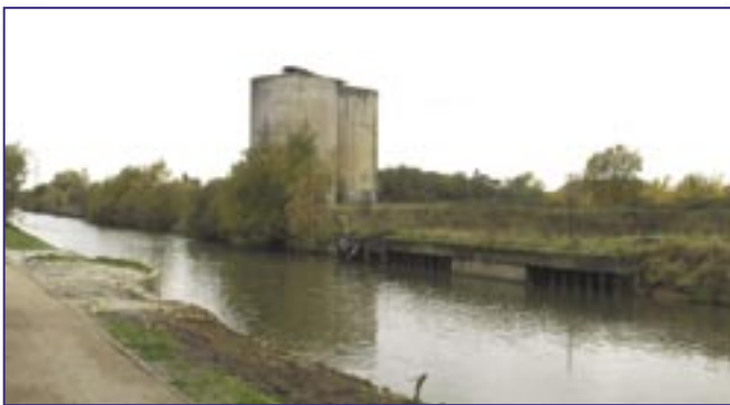
► Het braakliggend industrieterrein Pechiney Kuhlman
