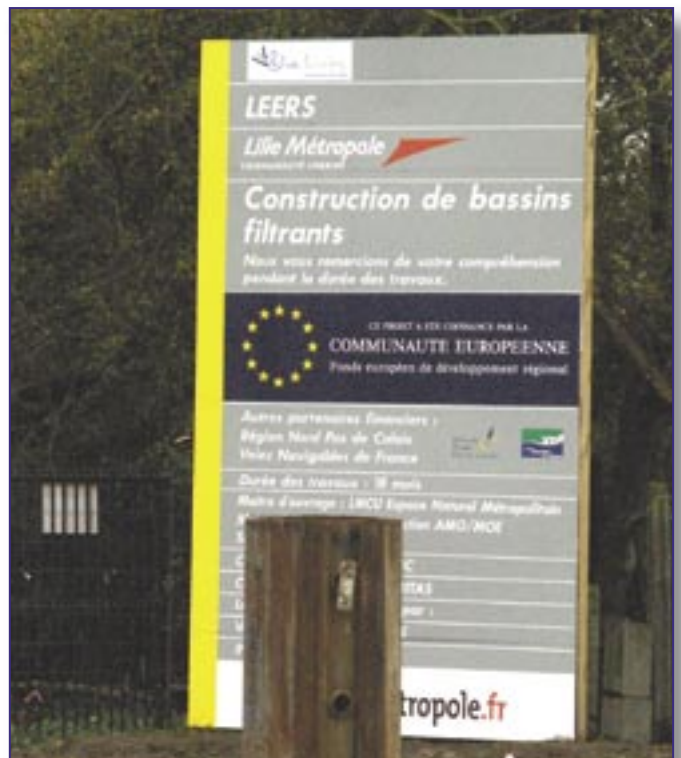
► Percolatiebekkens: werken in uitvoering
