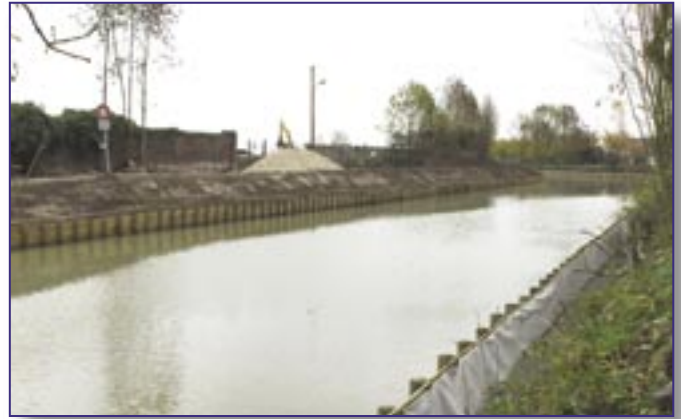
► De oeverherinrichtingswerken in Leers zijn in uitvoering
