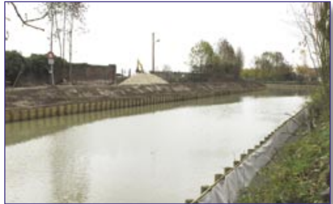
► Les travaux d'aménagement des berges sont en cours à Leers
