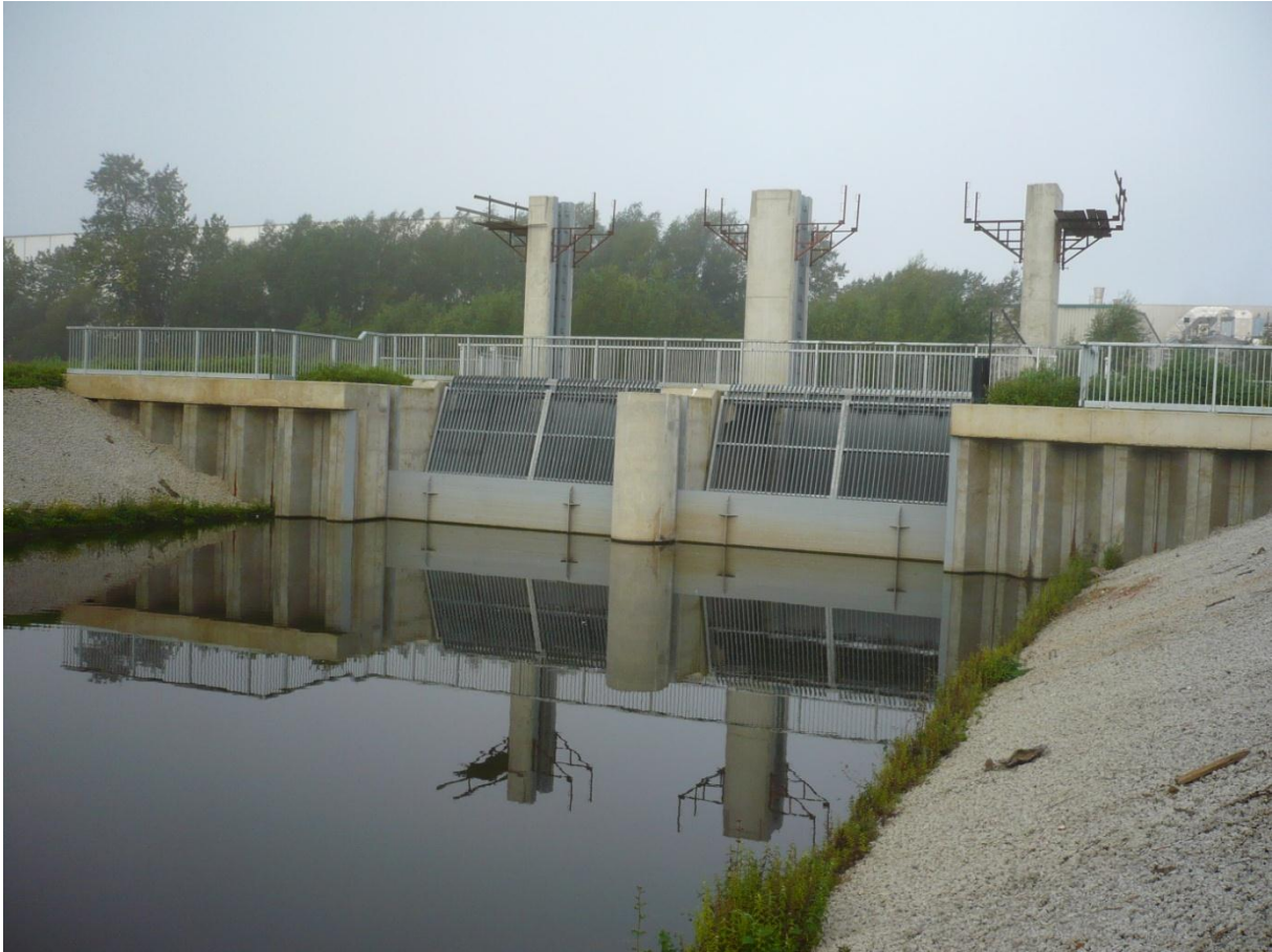
Foto: Gravitaire uitstroomconstructie tijdens bouwwerken
