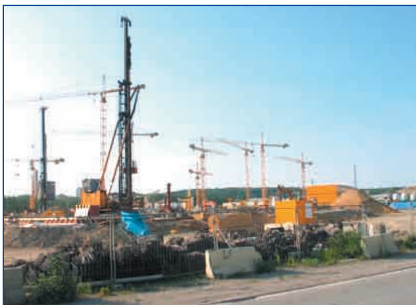
Vooruitgang van de werken aan het zuiveringsstation van Brussel-Noord
