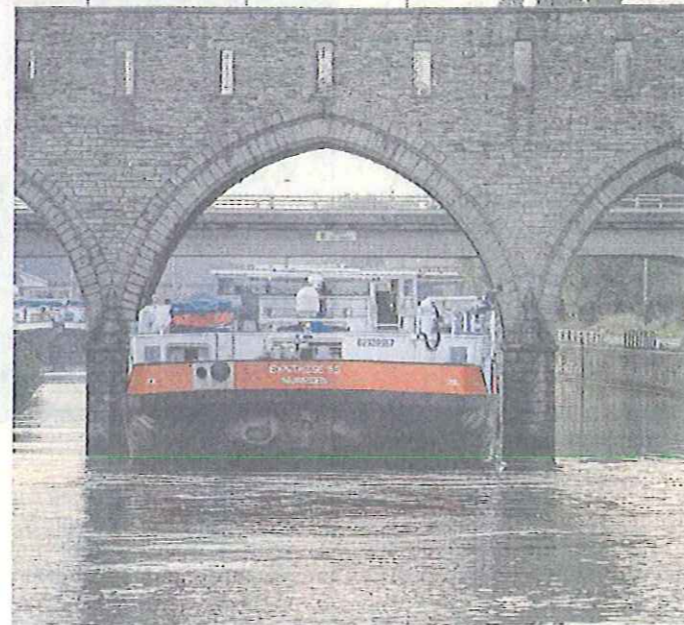
La capacité de transport passera à 2000 tonnes.
