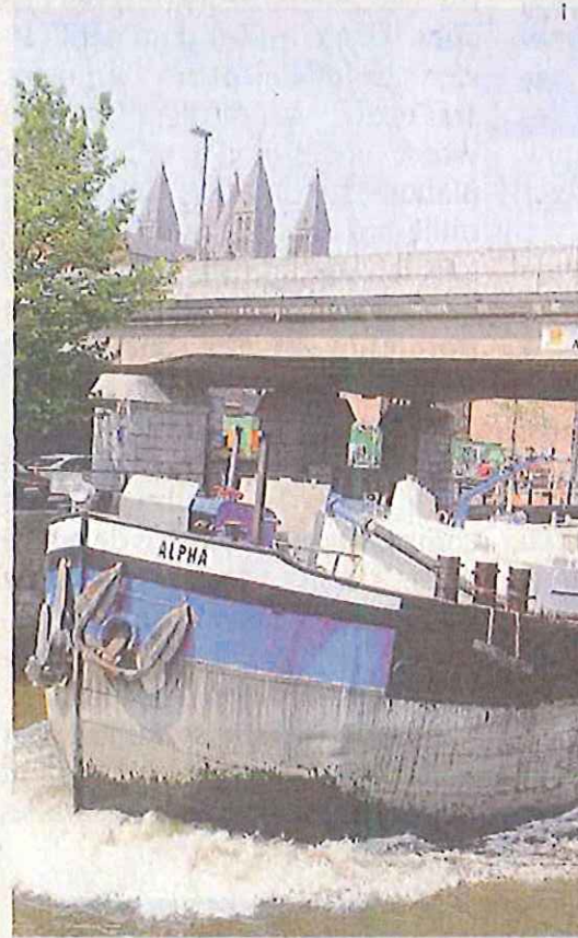
► Deux options existent pour le futur pont: détruire et le reconstruire. © DUPUIS
