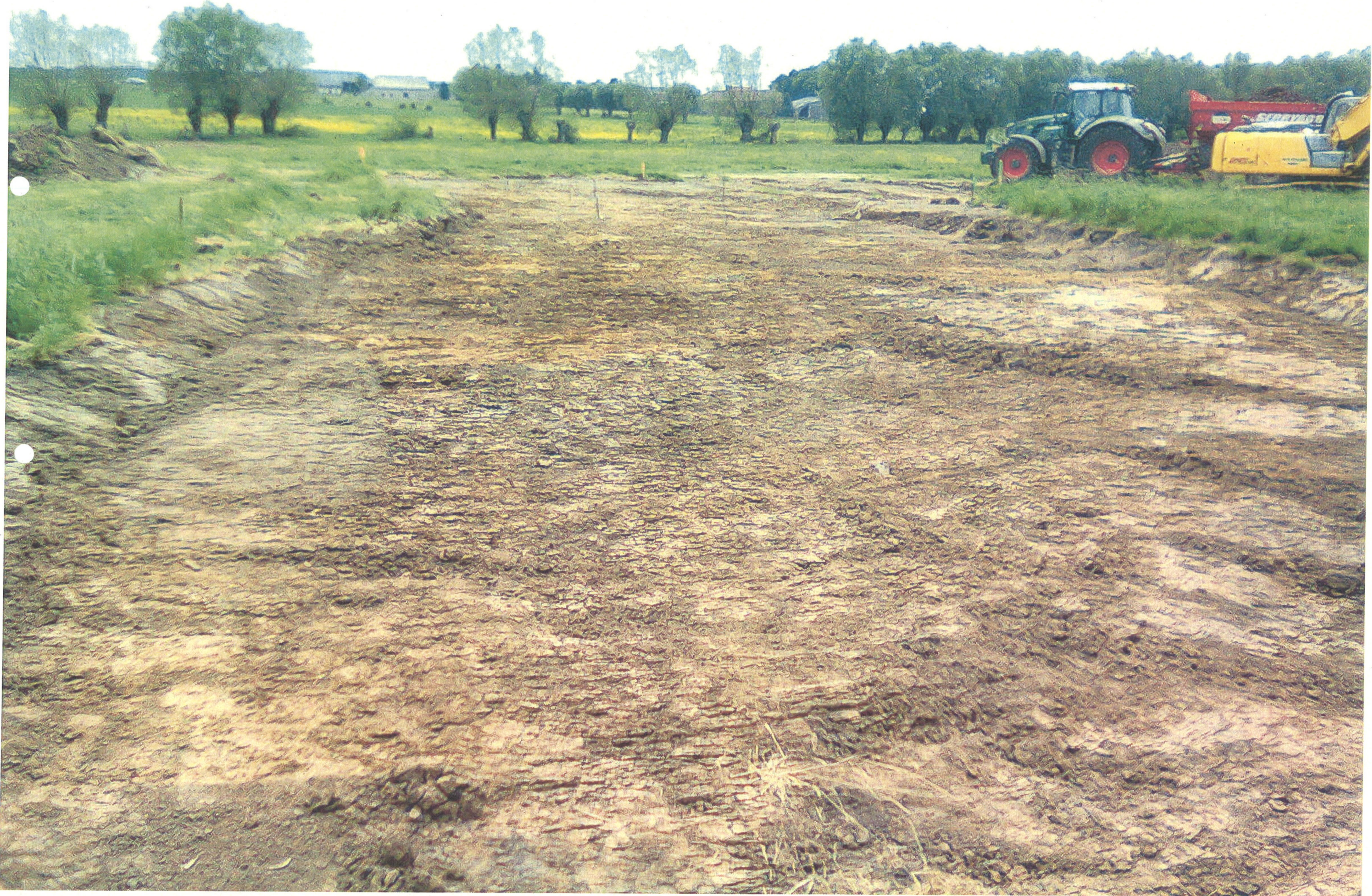
1. Afgraven zoden en teelaarde voor nieuw tracé meander
