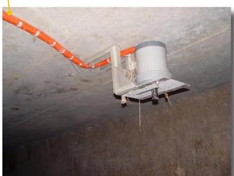
Sonde Ultrasons avec support et capot
