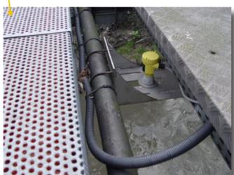
Sonde de niveau Radar sur la Senne
