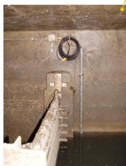
Mesure de niveau sur déversoir par sonde de pression
